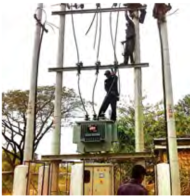
ရန်ကုန်မြို့တော် လျှပ်စစ်ဓာတ်အားပေးရေးအဖွဲ့မှ အများပြည်သူလျှပ်စစ်ဓာတ်အားပြည့်ဝစွာ သုံးစွဲနိုင်ရန်အတွက် ကြိုးပမ်းဆောင်ရွက်လျက်ရှိရာ ဇန်နဝါရီ ၁၅ ရက်က ရွှေပြည်သာမြို့နယ် (၁၅)ရပ်ကွက် အောင်သူခလမ်း ပန်းခြံ (၁၈) တွင် 11-6.6/0.4 KV, 200 KVA ထရန်စဖော်မာတစ်လုံး ဓာတ်အားလွှတ်ခြင်းလုပ်ငန်းကို မြို့နယ်အုပ်ချုပ်ရေးမှူး ဦးအောင်မိုးနှင့် မြို့နယ်လျှပ်စစ်အင်ဂျင်နီယာ ဦးမင်းမင်းဦးတို့ ဦးဆောင်၍ လိုင်းဝန်ထမ်းအဖွဲ့များက လုပ်ငန်းဆောင်ရွက်ခဲ့သည်။ (ယခုနှစ်အတွင်း ရွှေပြည်သာမြို့နယ်တွင် ထရန်စဖော်မာ ၃၉ လုံးတိုးချဲ့တပ်ဆင်ပြီးစီးခဲ့ပြီး မြောက်ပိုင်းခရိုင်အနေဖြင့် အလုံး ၁၀၀ ပြည့်ဓာတ်အားလွှတ်ခြင်းဖြစ်ကြောင်း သိရသည်။) (မြန်မာ့အလင်း)
