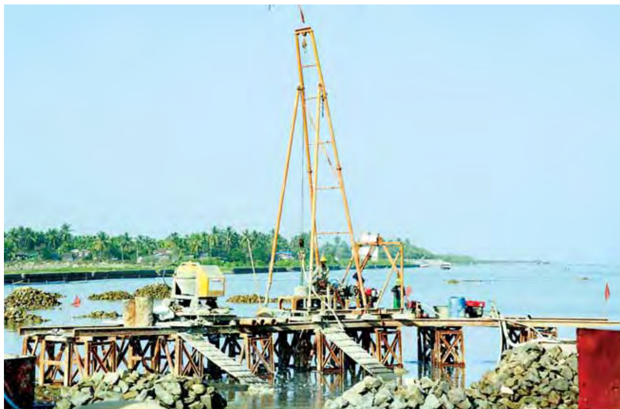
ရေကြီးရေလျှံမှုကိုကာကွယ်နိုင်ရန် ကုလားတန်မြစ်ဝ တည်ဆောက်ရေးလုပ်ငန်းခွင်ကို ဤသို့ တွေ့ရသည်။
