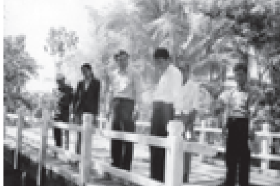
မော်လမြိုင်ကျွန်းမြို့နယ် စည်ပင်သာယာရေးအဖွဲ့ ဆောင်ရွက်သော မော်လမြိုင်ကျွန်း-တယ်ချောင်း ကျေးရွာအုပ်စု လမ်းပေါ်ရှိ မီးသုံးပိုချောင်းကူးတံတား တည်ဆောက်မှုမှတ်တမ်း ဇန်နဝါရီ ၈ ရက်က မြို့နယ်အေးချမ်းသာယာရေးနှင့် ဖွံ့ဖြိုးရေးကောင်စီဥက္ကဋ္ဌ ဦးအောင်ကျော်နိုင်နှင့် အမှုဆောင်အရာရှိ ဦးတင်လွင်ဦးတို့ ကျင်းပသောစစ်ဆေးရာ တာဝန်ခံအင်ဂျင်နီယာ သင်ဆန်းသန့်မြက ရှင်းလင်းတင်ပြစဉ်။ (မြို့နယ် စည်ပင်)
