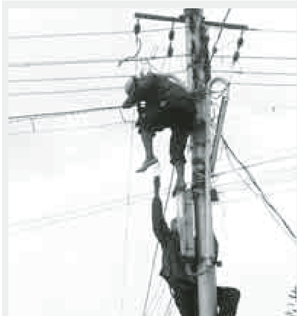
ရန်ကုန်တိုင်းဒေသကြီး သုံးခွမြို့ မြို့မဈေးအနီးရှိ ဓာတ်တိုင်များတွင် လျှပ်စစ် အန္တရာယ်ကင်းရှင်းစေရေးအတွက် ပုခက်ကြိုးနှင့် Earth Bar များကို သုံးခွမြို့နယ် လျှပ်စစ်အင်ဂျင်နီယာဌာနမှ ဝန်ထမ်းများက ဇူလိုင် ၂၁ ရက်က လိုက်လံတပ်ဆင် နေစဉ်။ ကိုကျော်(သုံးခွ)
