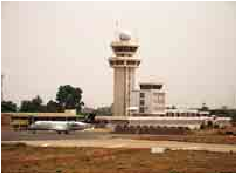
ဘူကီနာဖာဆိုနိုင်ငံတကာလေဆိပ်ရှိ လေကြောင်းထိန်းသိမ်းရေးမျှော်စင်ကို တွေ့ရစဉ်။
