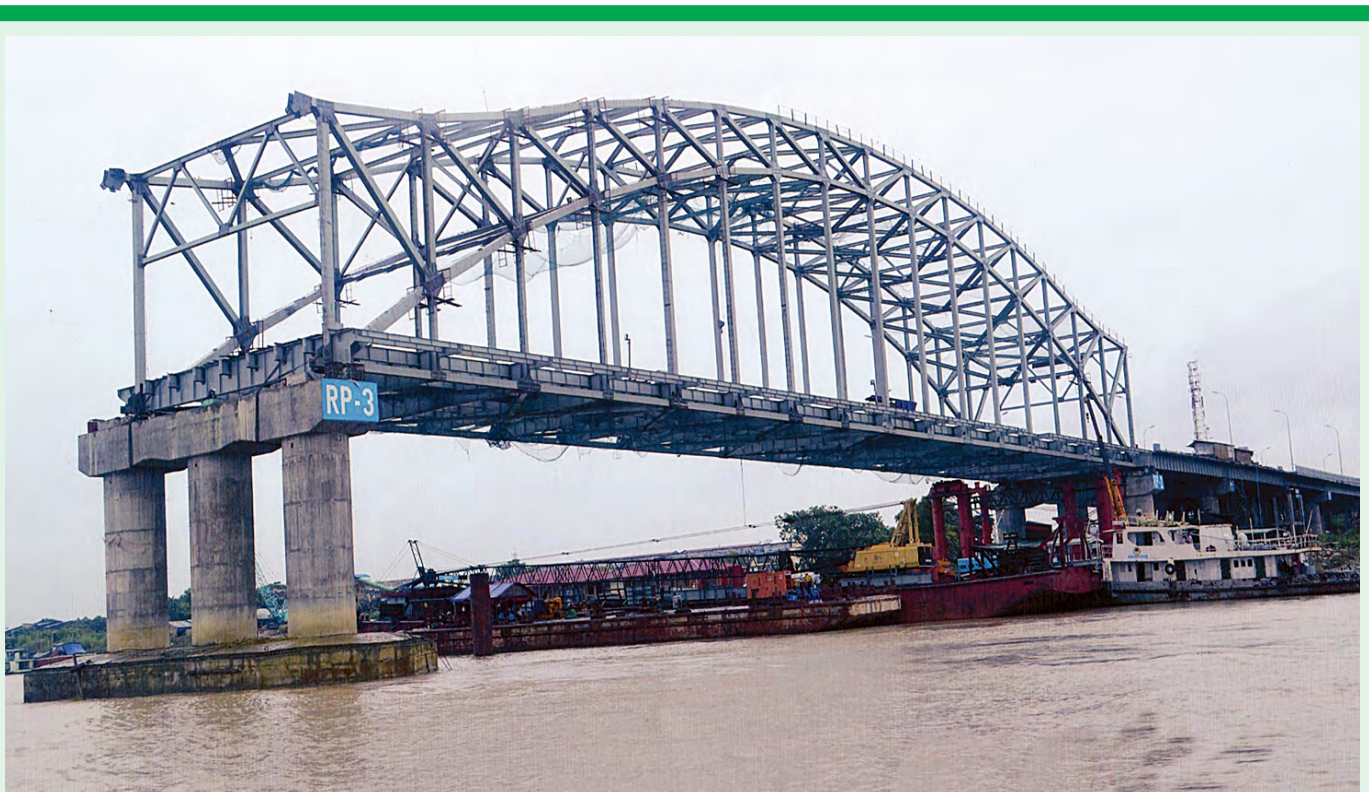
ရန်ကုန်မြို့၊ ဘုရင့်နောင်တံတားအမှတ်(၂)၏ ဘုရင့်နောင်ဘက်ကမ်း RP-2နှင့် RP-3 ကြား (၁၆) ခန်း သံပေါင်တပ်ဆင်ပြီးပုံနှင့်ပတ်သက်၍ ပြည်ထောင်စု အစိုးရအဖွဲ့၏ ၂၀၁၄-၂၀၁၅ ဘဏ္ဍာနှစ် ပထမလေးလပတ် အစည်းအဝေးသို့ တင်ပြစဉ် တွေ့မြင်ရပုံ။
