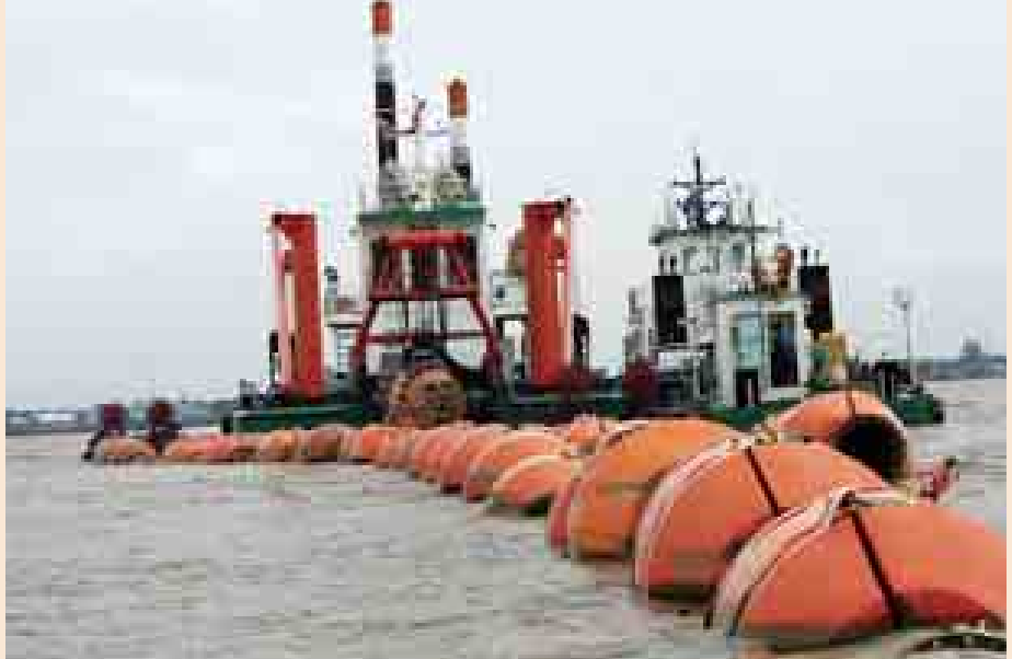
ဩဂုတ် ၁၇ ရက်က မေ့စေတီခေါင်းလောင်းကြီးဆယ်ယူရန် သောင်တူးစက်ဖြင့် ရေအောက်ရှိ ရွှံ့ညွန့်များကို စတင်ဖယ်ရှားနေသည်ကို ဤသို့တွေ့ရစဉ်။ သန်းထိုက်(လှိုင်သာယာ)
