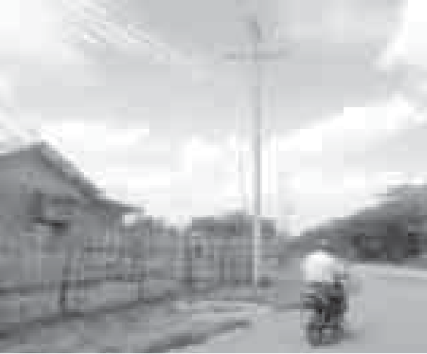
လျှပ်စစ်မီးလင်းရေးအတွက် ကွန်ကရစ်တိုင်များ စိုက်ထူထားရှိမှုကို တွေ့ရစဉ်။
