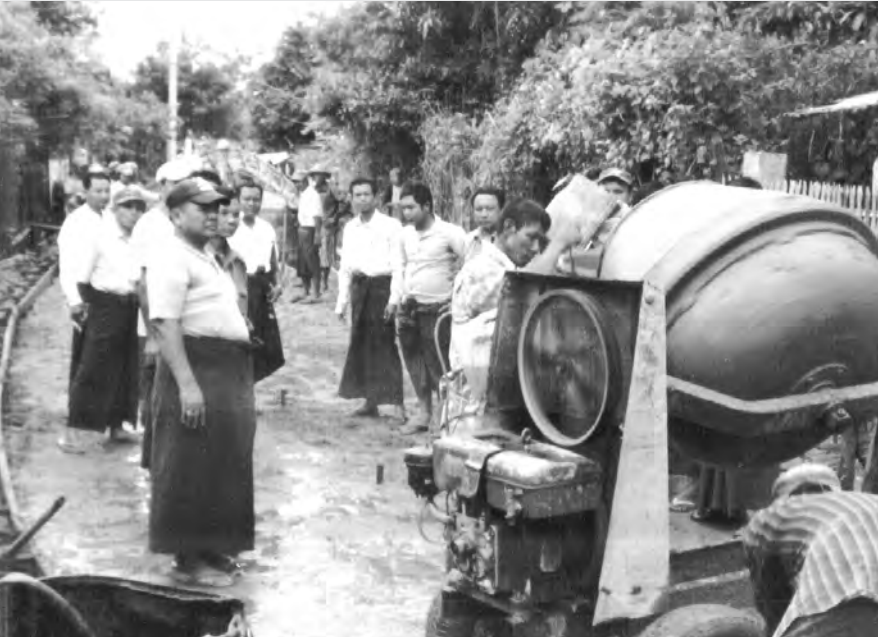
ရန်ကုန်တိုင်းဒေသကြီး၊ မင်္ဂလာဒုံမြို့နယ်၊ ထောက်ကြံ့မြောက်ပိုင်းရပ်ကွက်ဒေသဖွံ့ဖြိုးရေးအတွက် ဘောဂမြိုင်လမ်းမကြီးအား ကွန်ကရစ်လမ်းခင်းခြင်းကို ဖြို့တော်စည်ပင်တာဝန်ခံအင်ဂျင်နီယာ ဒေါ်အေးအေးပိုင်၊ ရပ်ကွက်အုပ်ချုပ်ရေးမှူးဦးမျိုးလွင်ထွေးနှင့်အဖွဲ့၊ ရပ်မိရပ်ဖများမှ လမ်းခင်းနေမှုအခြေအနေအား အနီးကပ်ကြီးကြပ် ဆောင်ရွက်နေကြကြောင်း သိရသည်။ သတင်းနှင့်ဓာတ်ပုံ- ဇော်ငြိမ်း(မင်္ဂလာဒုံ)
