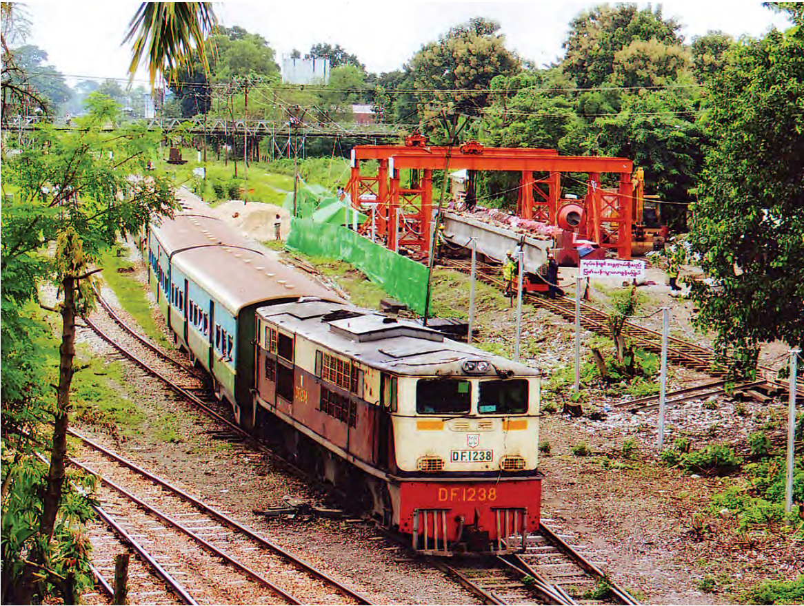
မီးရထားခုံးကျော်တံတားသစ် တည်ဆောက်ရေးလုပ်ငန်းခွင်တွင် တံတားသစ်ကြီးတည်ဆောက်ရန်အတွက် ဘိုးပိုင်များ၊ ရက်မများ တည်ဆောက်မှုကို ဩဂုတ် ၁၆ ရက်က တွေ့ရစဉ်။
