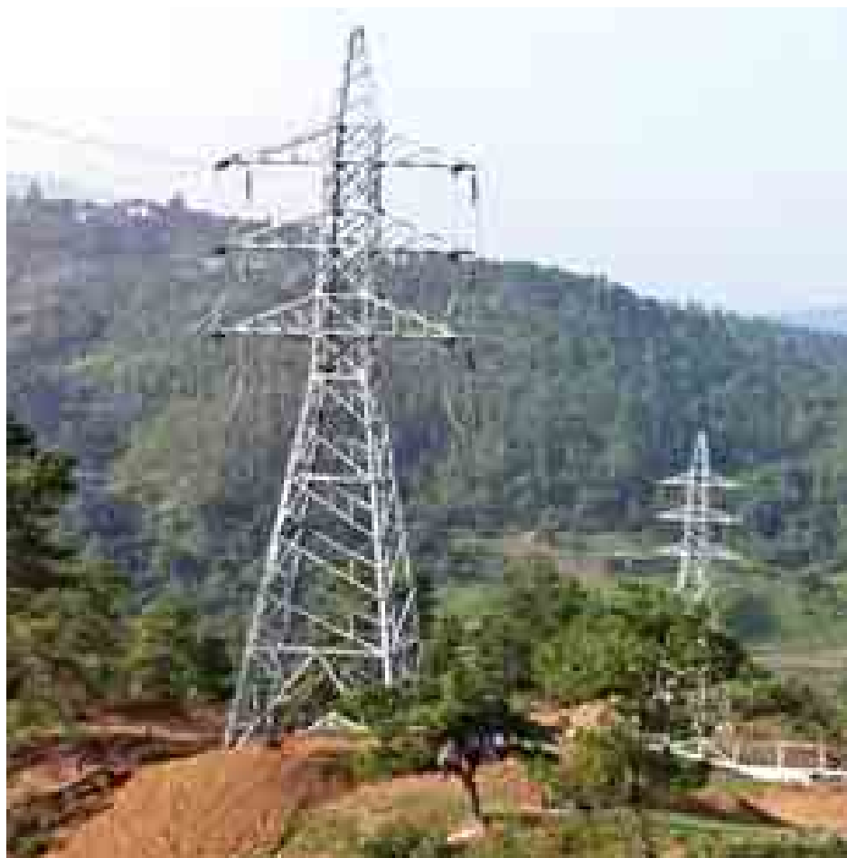
၆၆ ကေပွီ ဂန့်ဂေါ-ဟားခါး ဓာတ်အားလိုင်း တည်ဆောက်ပြီးစီးမှုကို တွေ့ရစဉ်။
