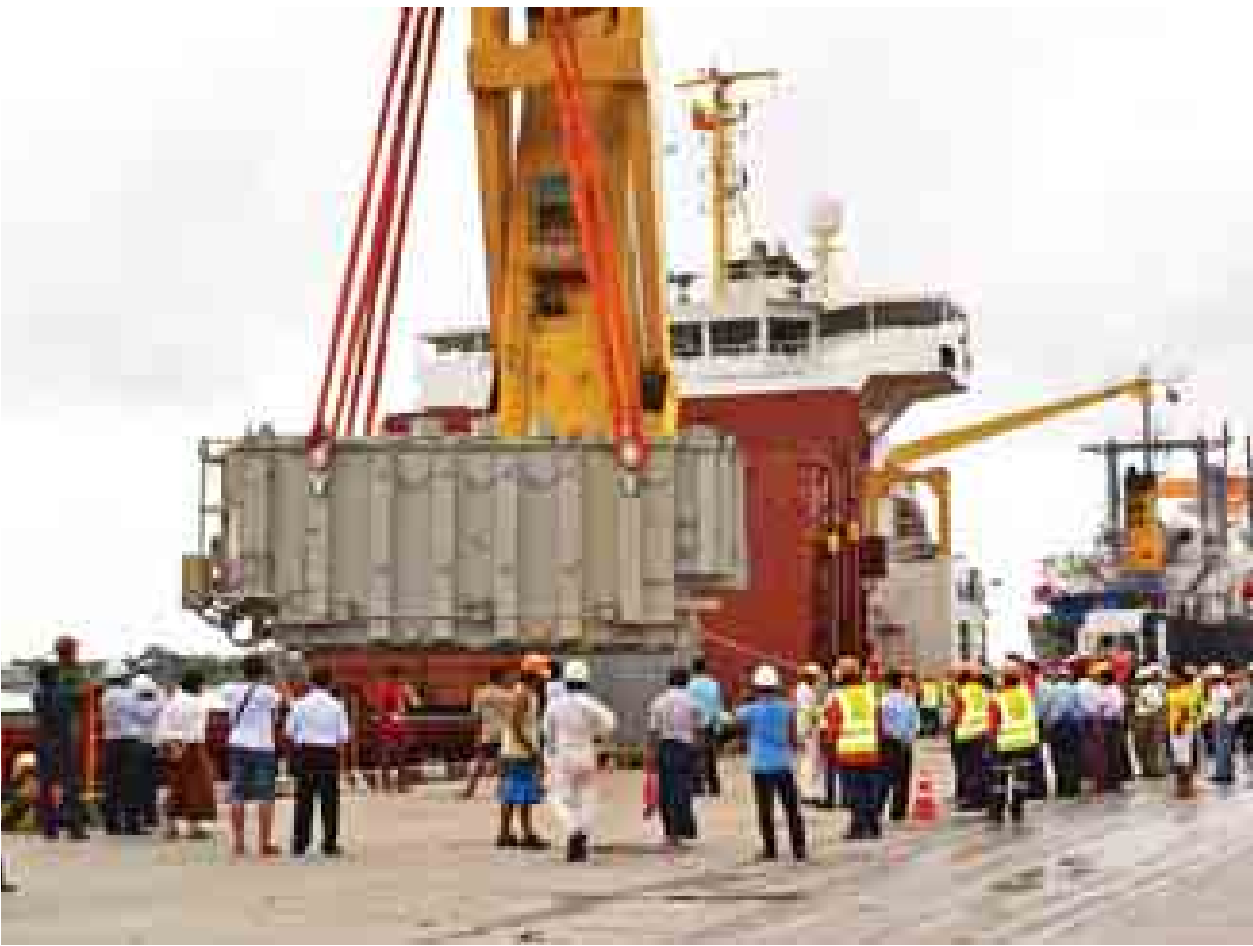
ရန်ကုန်မြို့ ဒဂုံမြို့သစ်(အရှေ့ပိုင်း)မြို့နယ် အမှတ်(၇)လမ်းမကြီးပေါ်တွင် တည်ဆောက်လျက်ရှိသော ဓာတ်အားခွဲရုံတွင်တပ်ဆင်မည့် ကိုရီးယားသမ္မတ နိုင်ငံမှ ဝယ်ယူရောက်ရှိလာသော ထရန်စဖော်မာများအား သင်္ဘောပေါ်မှသယ်ချနေစဉ်။ (သတင်းစဉ်)
