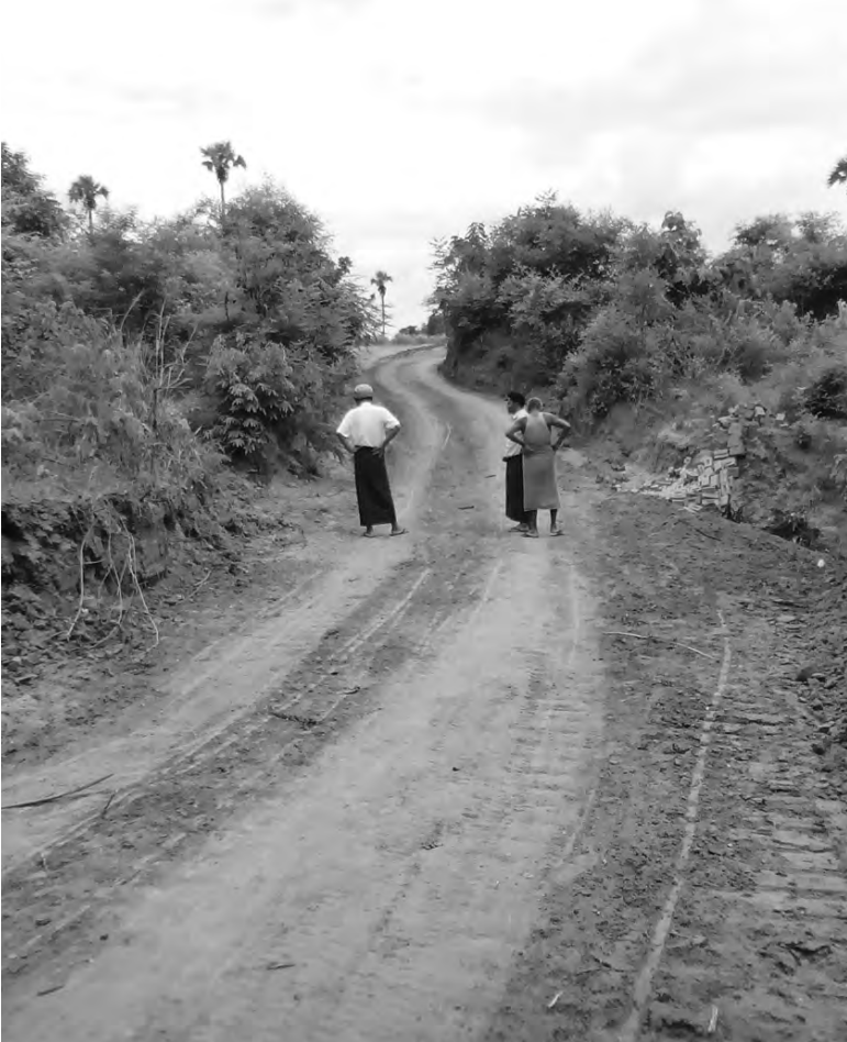
ချောင်းဆုံ-ကွင်းစပ်-အလောင်းတော်ကဿပလမ်း အဆင့်မြှင့်တင်ပြီးစီးမှုအနေအထားအား တွေ့ရစဉ်။
