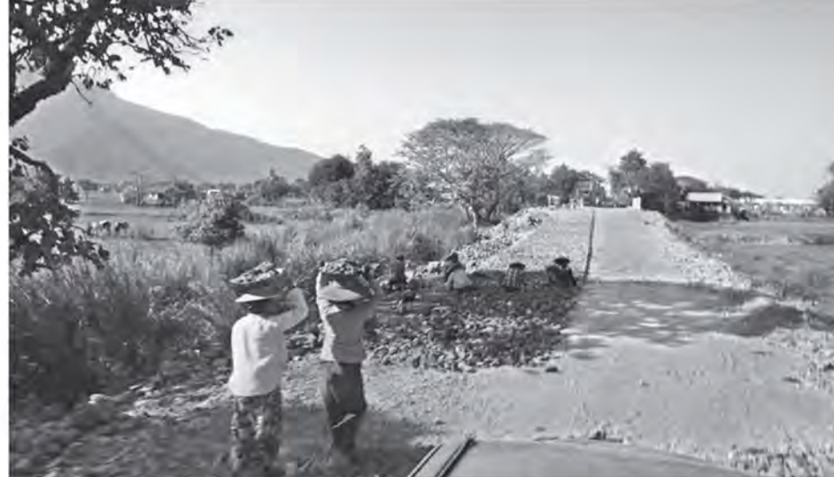
အာရှပတ်လမ်းပေါ်ရှိ တံတားချဉ်းကပ်လမ်းတစ်ခုရှိ အမာခံမြေဖိုခြင်းလုပ်ငန်းများ ဆောင်ရွက်နေစဉ်။
