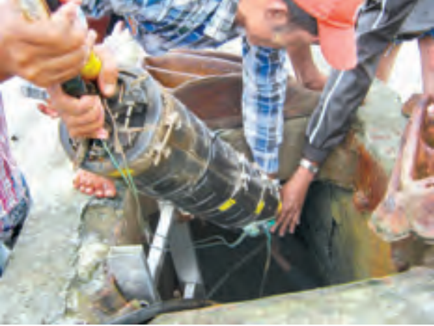
အင်တာနက် ကေဘယ်ဆက်ကြောင်း ချွတ်ယွင်းသွားမှုကို ဝန်ထမ်းများ အစားထိုးတပ်ဆင်ဆောင်ရွက်နေသည်ကို တွေ့ရစဉ်။
