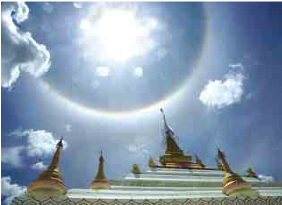
စစ်ကိုင်းတိုင်းဒေသကြီး စစ်ကိုင်းခရိုင် မြောင်မြို့နယ် ကျောက်ရစ်ကျေးရွာ၌တည်ထားသော ရွှေပေါင်လောင်စေတီတော်ကြီး ထက်ကောင်းကင်၌ ဇွန် ၈ ရက် (နံနက် ၈နာရီ ၅မိနစ်ခန့်)က ထူးထူးခြားခြား နေထီးဆောင်းနေမှုကို ဖူးတွေ့ရစဉ်။
