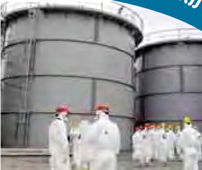
ပူကူရှီးမား မျှတလီးယားစက်ရုံ၌ မြေအောက်ရေခဲတံတိုင်းနံရံကို တည်ဆောက်ရန် ပြင်ဆင်ဆောင်ရွက်စဉ်။
