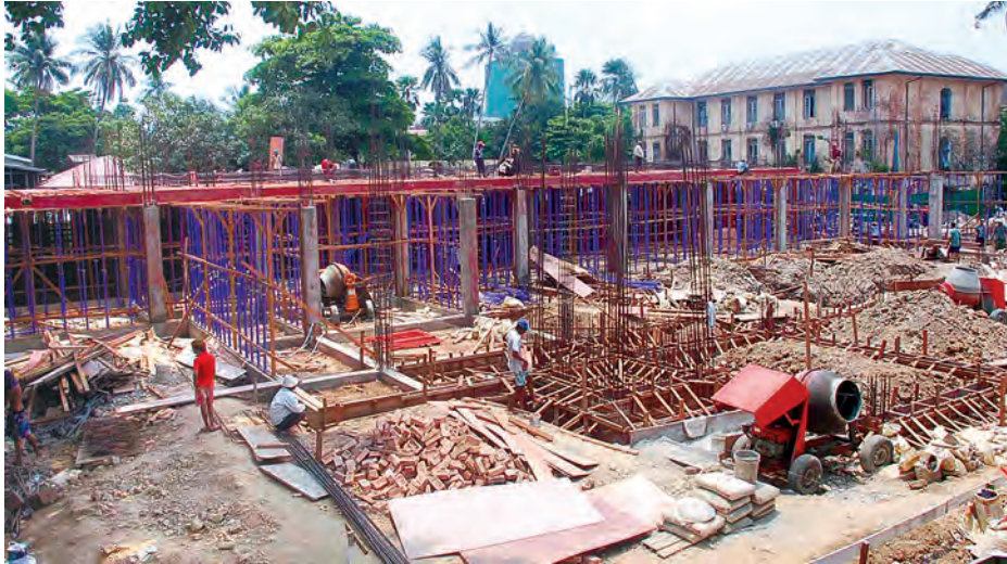
ရန်ကုန်ပြည်သူ့ဆေးရုံကြီးအတွင်း အဆောင်သစ်များ ဆောက်လုပ်နေသည်ကို တွေ့ရရန်။
