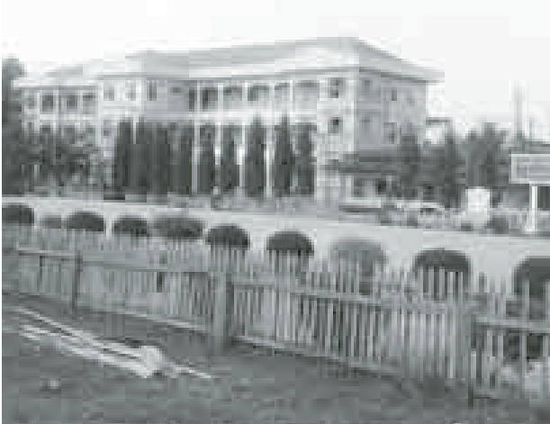
တည်ဆောက်ပြီးစီးနေသော ရွှေကုက္ကိုလ်မြိုင် အထက်တန်းကျောင်း သုံးထပ်ကျောင်းဆောင်သစ်အား တွေ့ရစဉ်။
