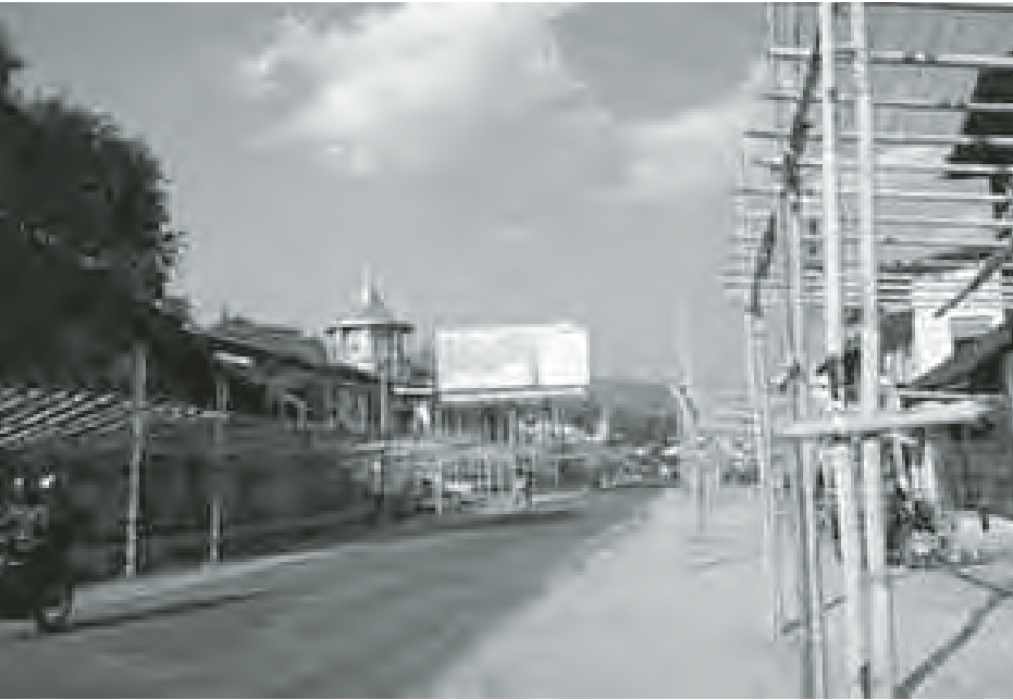
ဗုဒ္ဓပူဇနိယပွဲတော်အတွက် ဆိုင်ခန်းများ ဆောက်လုပ်ထားစဉ်
