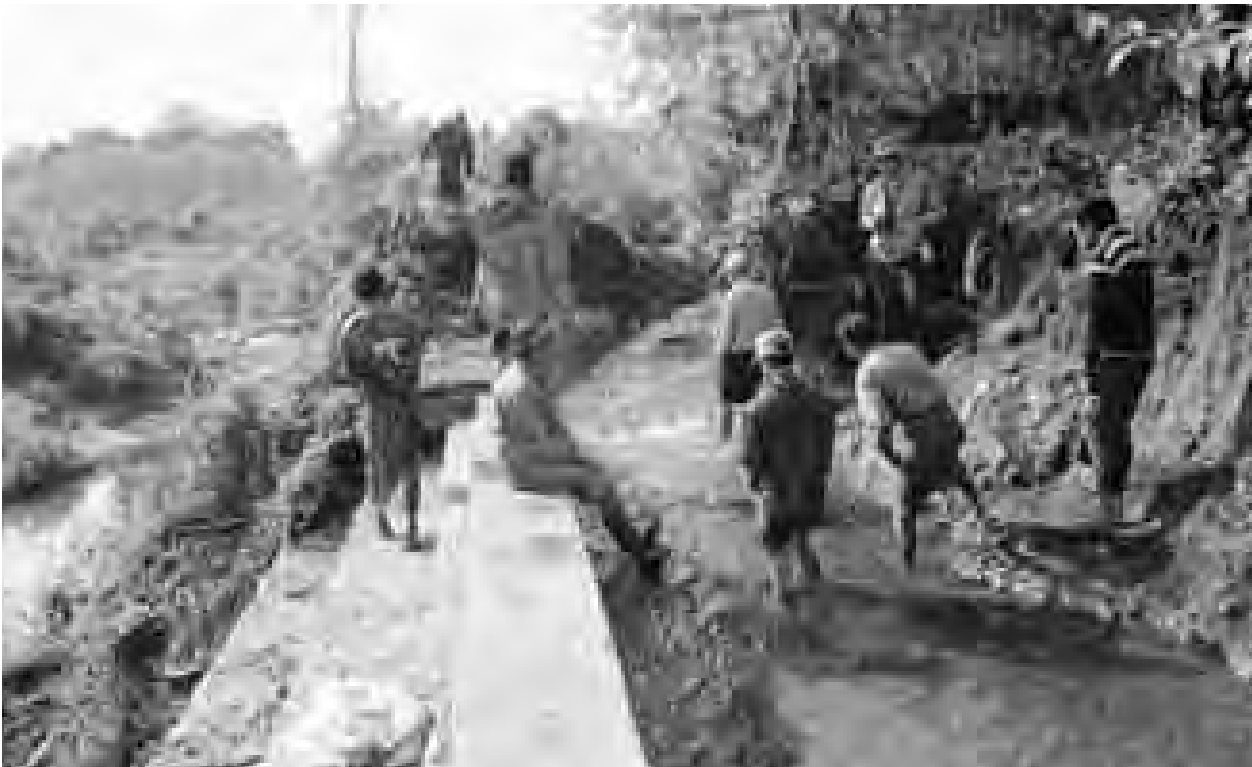
မန္တလေးတိုင်းဒေသကြီး၊ သပိတ်ကျင်းမြို့နယ်၊ အုံးပိုင်ကျေးရွာရှိ စိုက်ပျိုးရေးရရှိရေးအတွက် ရေမြောင်းကွန်ကရစ်တည်ဆောက်မှုလုပ်ငန်းခွင်အား တွေ့ရစဉ်။
