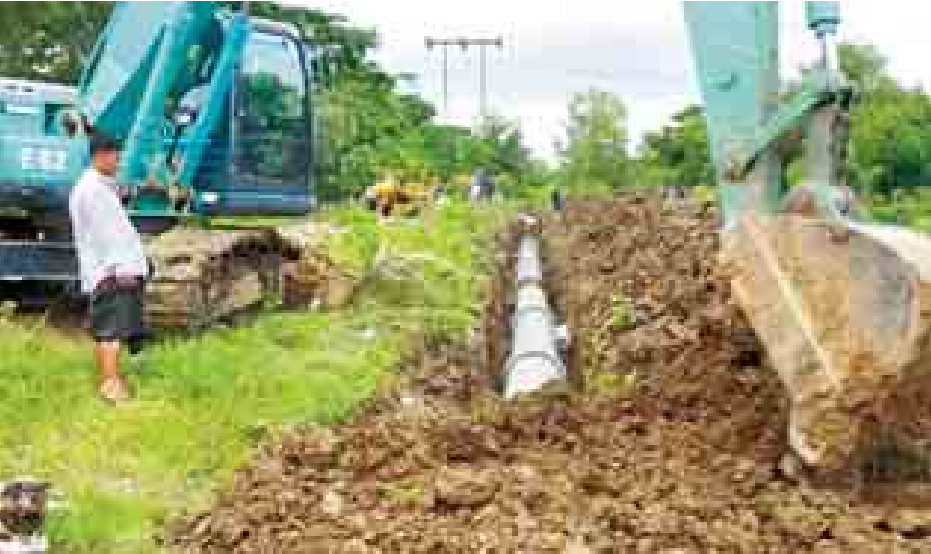
ဒလမြို့နယ်တွင် ၂၄ လက်မ ကွန်ကရစ်ပိုက်လိုင်း (၄ ဒဿမ ၅)မိုင် ဆက်သွယ်ခြင်းလုပ်ငန်း ဆောင်ရွက်နေမှု ကိုတွေ့ရစဉ်။
