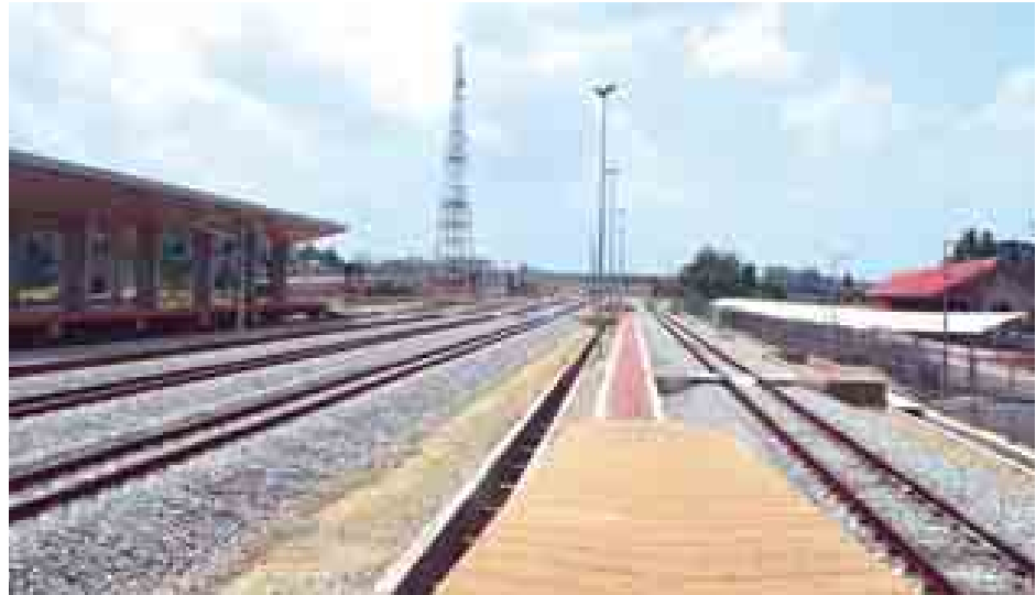
နိုင်ငံခြားတွင် ရထားလမ်းတစ်လျှောက် ဖိုင်ဘာဆက်ကြောင်းများဆောင်ရွက်ထားရှိမှုကို တွေ့ရစဉ်။
