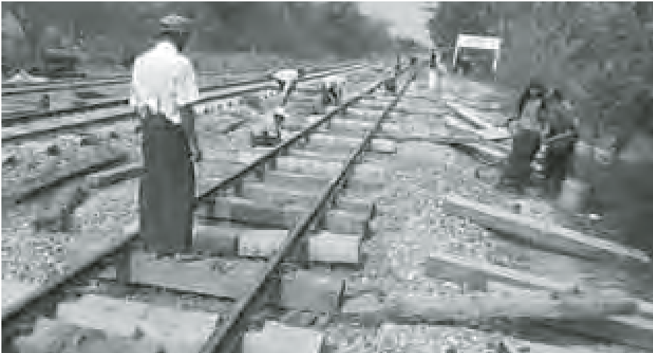
တွင် မီးရထားလမ်းကျောက်ဖြည့်တင်းခြင်း၊ ကွန်ကရစ်လီမောင်းတုံး ပြောင်းလဲခြင်းကြောင့် ရထားလမ်းချော်မှု မရှိတော့ကြောင်း အငယ်တန်းအင်ဂျင်နီယာက ပြောသည်။
