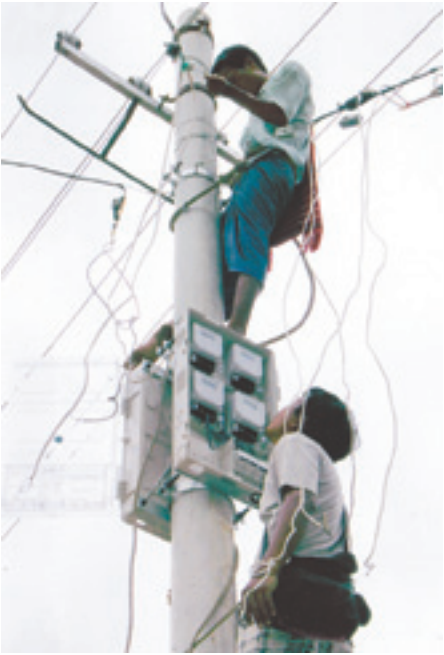
ဇူလိုင် ၁၈ ရက်က နေပြည်တော်ကောင်စီနယ်မြေတပ်ကုန်းမြို့၌ လက်ရှိ အသုံးပြုလျက် ရှိသော ( Analog ) မီတာများ အစား ( Digital ) မီတာများဖြင့် လဲလှယ် တပ်ဆင်လျက်ရှိရာ မြို့ပေါ်ရှိ မီးသုံးစွဲသူ ၅၀၀၀ ကျော်၏ မီတာများ အား လုံးကို လဲလှယ်တပ်ဆင်နေစဉ်။ တင်ထွန်းတာ
