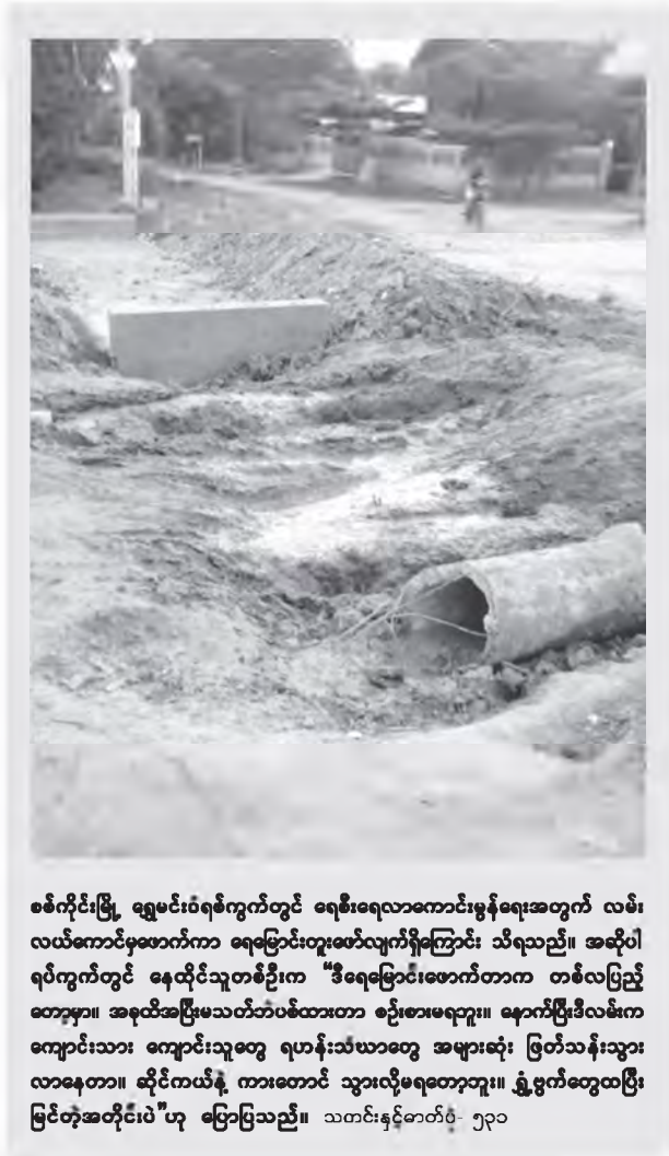
စစ်ကိုင်းမြို့ ရွှေမင်းဝံရစ်ကွက်တွင် ရေစီးရေလာကောင်းမွန်ရေးအတွက် လမ်းလယ်ကောင်မှဖောက်ကာ ရေမြောင်းတူးဖော်လျက်ရှိကြောင်း သိရသည်။ အဆိုပါရုပ်ကွက်တွင် နေထိုင်သူတစ်ဦးက “ဒီရေမြောင်းဖောက်တာက တစ်မပြည့်တော့မှာ။ အခုထိအပြီးမသတ်ဘဲပစ်ထားတာ စဉ်းစားမရဘူး။ မောက်ပြီးဒီလမ်းက ကျောင်းသား ကျောင်းသူတွေ ရဟန်းသံဃာတွေ အများဆုံး ဖြတ်သန်းသွားလာနေတာ။ ဆိုင်ကယ်နဲ့ ကားတောင် သွားလို့မရတော့ဘူး။ ဖွဲ့ရွက်တွေထပြီး မြင်တဲ့အတိုင်းပဲ”ဟု ပြောပြသည်။ သတင်းနှင့်မာတိတ် ၅၃၀
