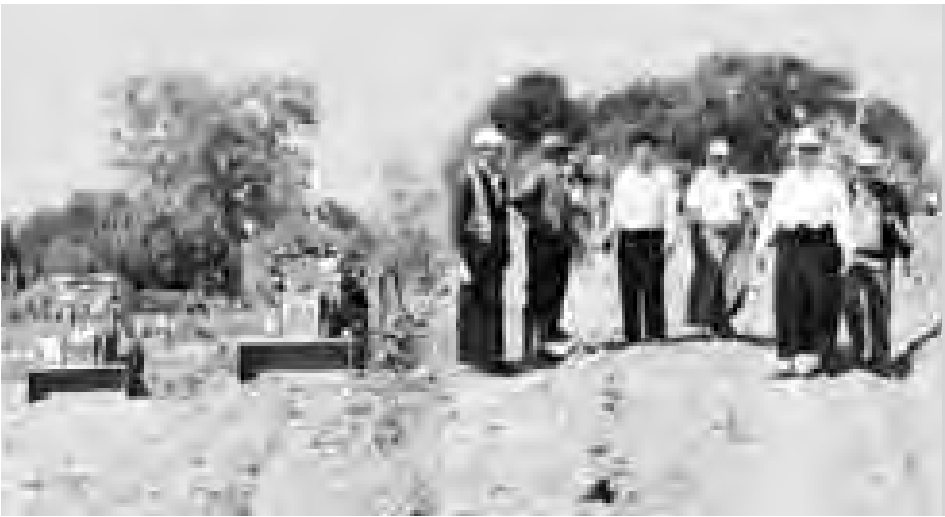
ယူဇလယ်-ဂဇက်-ဆည်ကြီးကျေးရွာချင်းဆက်လမ်းဖောက်လုပ်နေမှုအား ကြည့်ရှုစစ်ဆေးစဉ်။
