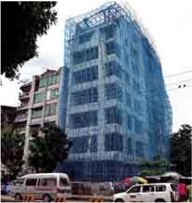
ရန်ကုန်မြို့ တာမွေမြို့နယ်ရှိ တရားဝင်ခွင့်ပြုချက်ရပြီး တည်ဆောက်နေသော လူနေတိုက်တာအဆောက်အအုံကို တွေ့ရစဉ်။
