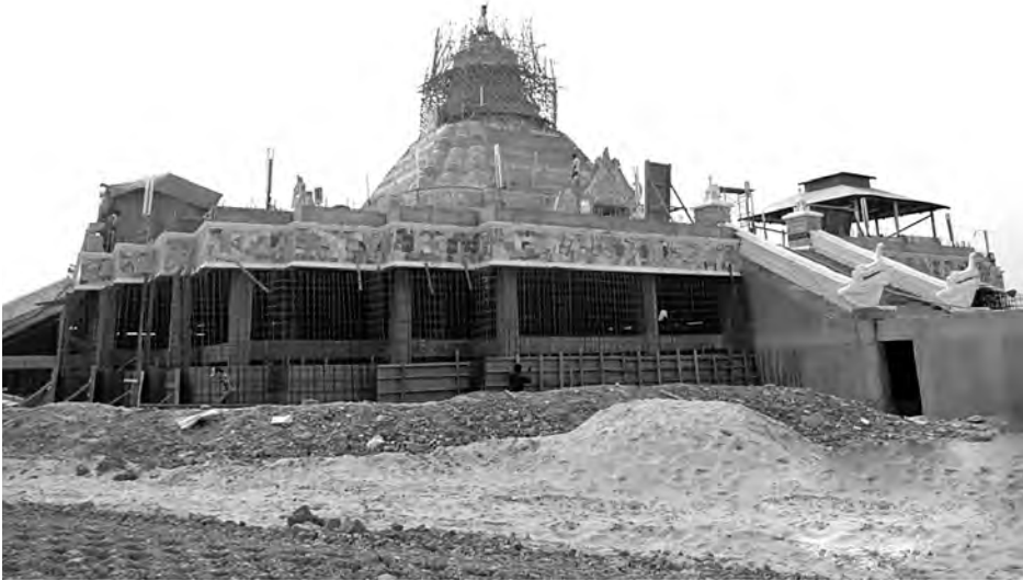
အမရပူရမြို့နယ်ရှိ ဝေရောစနကျောက်စိမ်းစေတီတော်မြတ်ကြီး တည်ဆောက်နေမှုကိုတွေ့ရစဉ်။
