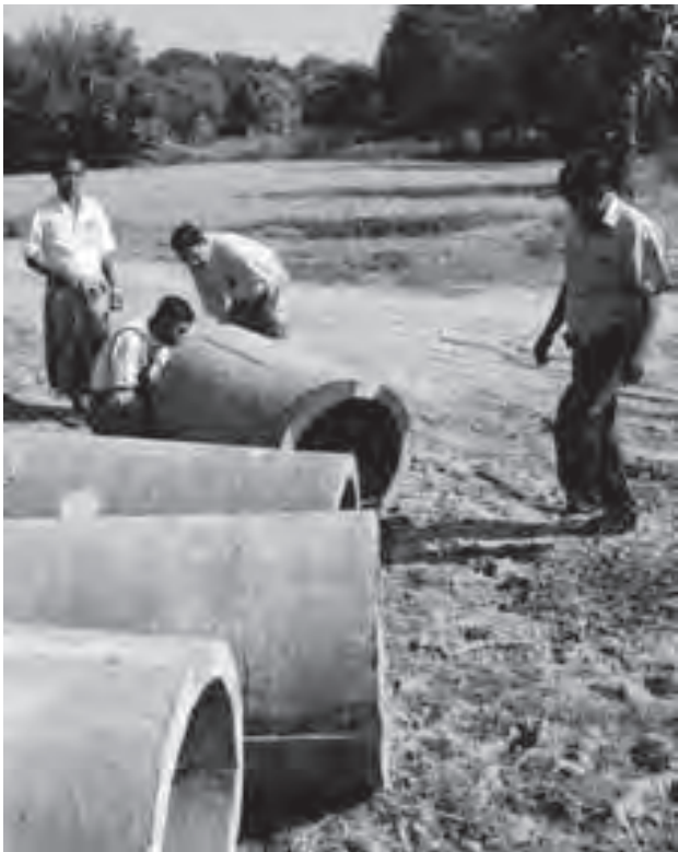
အိုင်ကြီးလည်ကျေးရွာနှင့် ဝါရုံကျေးရွာတို့၏ကျေးရွာချင်းဆက်ပြေသားလမ်းပေါ်တွင် ရေပြန်တပ်ဆင်ပေးခြင်းလုပ်ငန်းခွင်။
