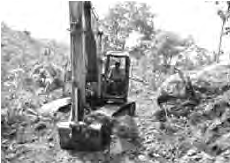
ကျောက်ဖျာကျေးရွာနှင့် ရွာသစ်ကုန်းကျေးရွာချင်းဆက်လမ်းအား မြေသားလမ်းအဖြစ် ဖောက်လုပ်နေမှုကို တွေ့ရစဉ်။
