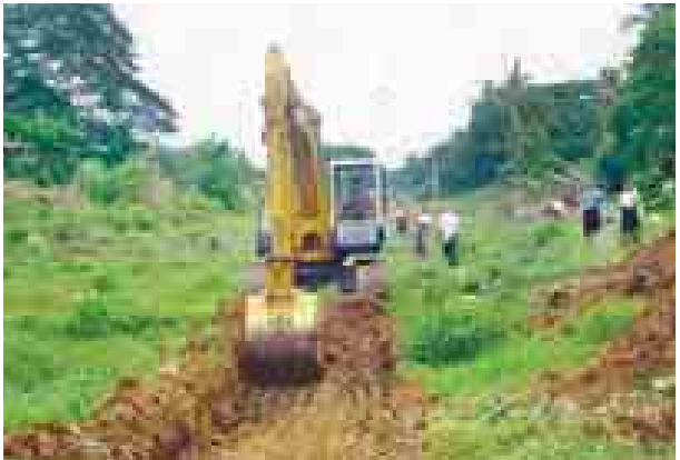
နေပြည်တော်ကောင်စီနယ်မြေ ယဉ်းမနားမြို့တွင် မိုးတွင်းကာလရေကြီးနစ်မြုပ်မှု မရှိစေရန် ပေါင်းလောင်းနယ်မြေ(၁)သပြေလမ်းမှ ပေါင်းလောင်းနယ်မြေ(၃) ရာဇဌာနီလမ်းမကြီးအထိ ရန်ကုန်-မန္တလေးမီးရထားလမ်း အရှေ့ဘက်ဘေးရှိ ပင်မရေမြောင်းကို စက်ကြီးများဖြင့် ဖောက်လုပ်မှုကို ၈၆ ၁၈ ရက်ကတွေ့ရစဉ်။
