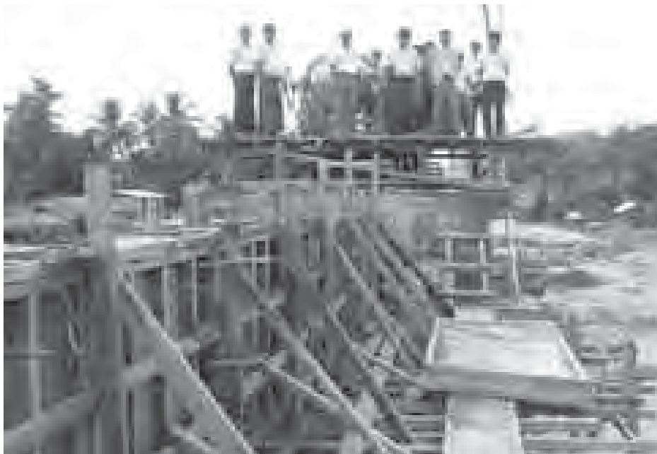
ဆည်ကြီးတံတား၏ဆောက်လုပ်နေမှုကို ကလေးခရိုင်မှ သက်ဆိုင်ရာတာဝန်ရှိသူများက ကြိမ်မတ်စစ်ဆေးဆောင်ရွက်စဉ်။
