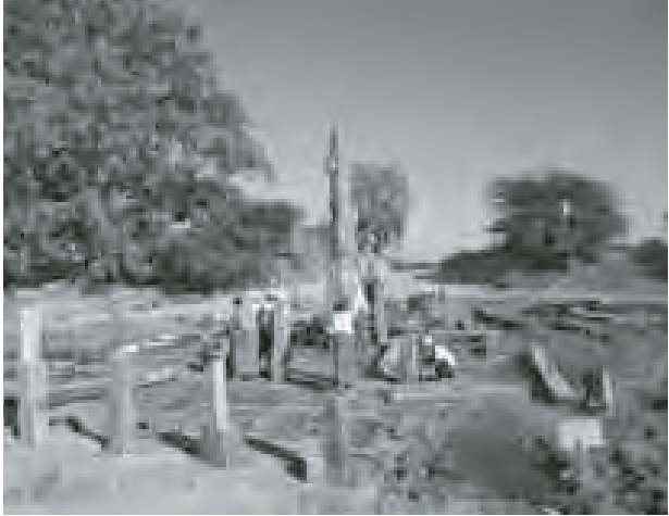
သစ်သားတံတား တည်ဆောက်နေမှုကို မြင်တွေ့ရစဉ်။
