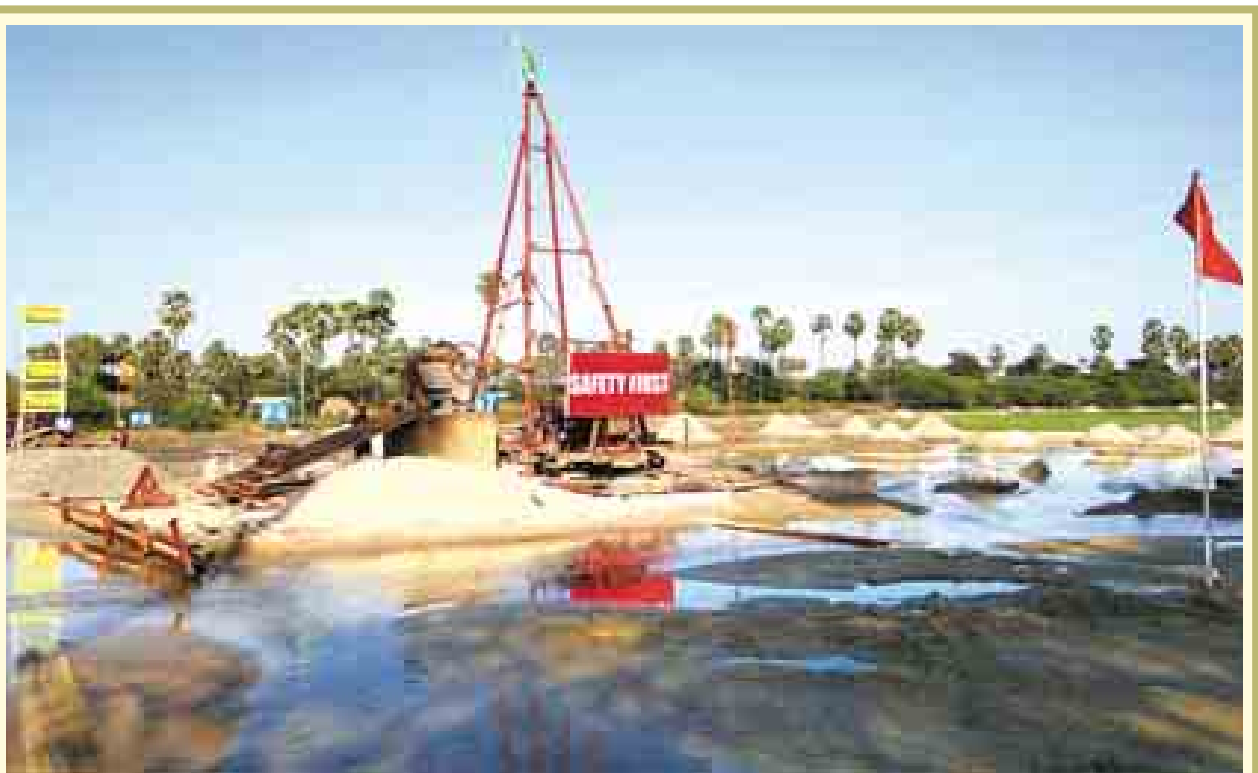
မြင်းခြံခရိုင် တောင်သာမြို့နယ်၌ လမ်းဆောက်လုပ်ရေးစီမံကိန်း အထူးအဖွဲ့ (၄) က တာဝန်ယူတည်ဆောက်နေသော ကိုင်းချောင်းတံတား တည်ဆောက်ရေး လုပ်ငန်းခွင်ကို တွေ့ရစဉ်။
