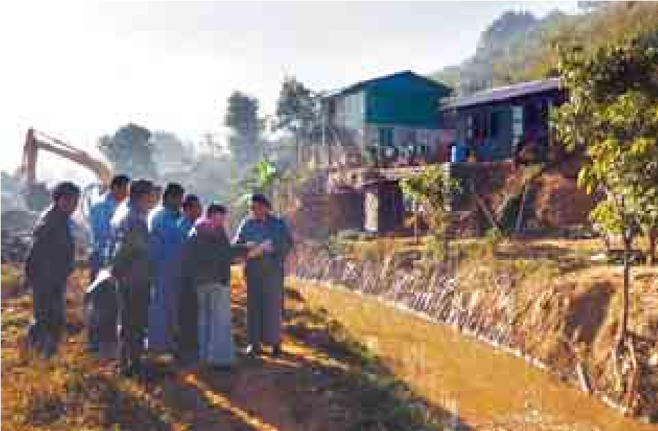
အမှတ်(၇)အခြေခံပညာ အလယ် တည်ဆောက်လျက်ရှိသော ပေ ၁၄၀၊ တန်းကျောင်း၊ အမက(၁၁)အလက(ခွဲ) ပေ ၃၀ရှိ အာရ်စီနှစ်ထပ် ကျောင်း တွင် K.Z.E.N ကုမ္ပဏီမှ တာဝန်ယူ ဆောင်သစ် ဆောက်လုပ်နေမှု တို့ကို ကြည့်ရှုစစ်ဆေးခဲ့ကြောင်း သိရသည်။ (အပေါ်ပုံ) ဟန်ဌေး(iprd)
