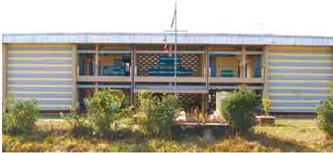
ဒိုက်ဦးမြို့နယ်၌ ဆောက်လုပ်ထားသော အာရ်စီနစ်ထပ်ကျောင်းဆောင်သစ်ကို တွေ့ရစဉ်။
