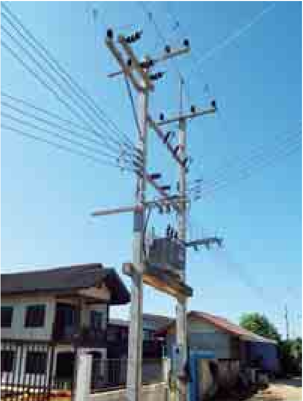
Insulated Cable မှတစ်ဆင့် Connector များဖြင့် အသုံးပြု၍ ဓာတ်အားဖြန့်ဖြူးထားပုံ။
