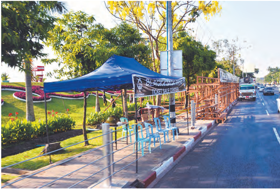
ရန်ကုန်မြို့ သင်္ကြန်ကာလ နှဲပျော်ရန်အတွက် သင်္ကြန်မဏ္ဍပ်များ ဆောက်လုပ်နေမှုကို တွေ့ရစဉ်။
