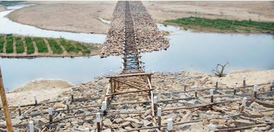
ဂဝံကျောက်များဖြင့် ကျောက်ခင်းရေကာတာ သုံးခုကို တည်ဆောက်လျက်ရှိသည့် ရေကြိုမြို့မှ လုပ်ငန်းခွင်မြင်ကွင်း။
