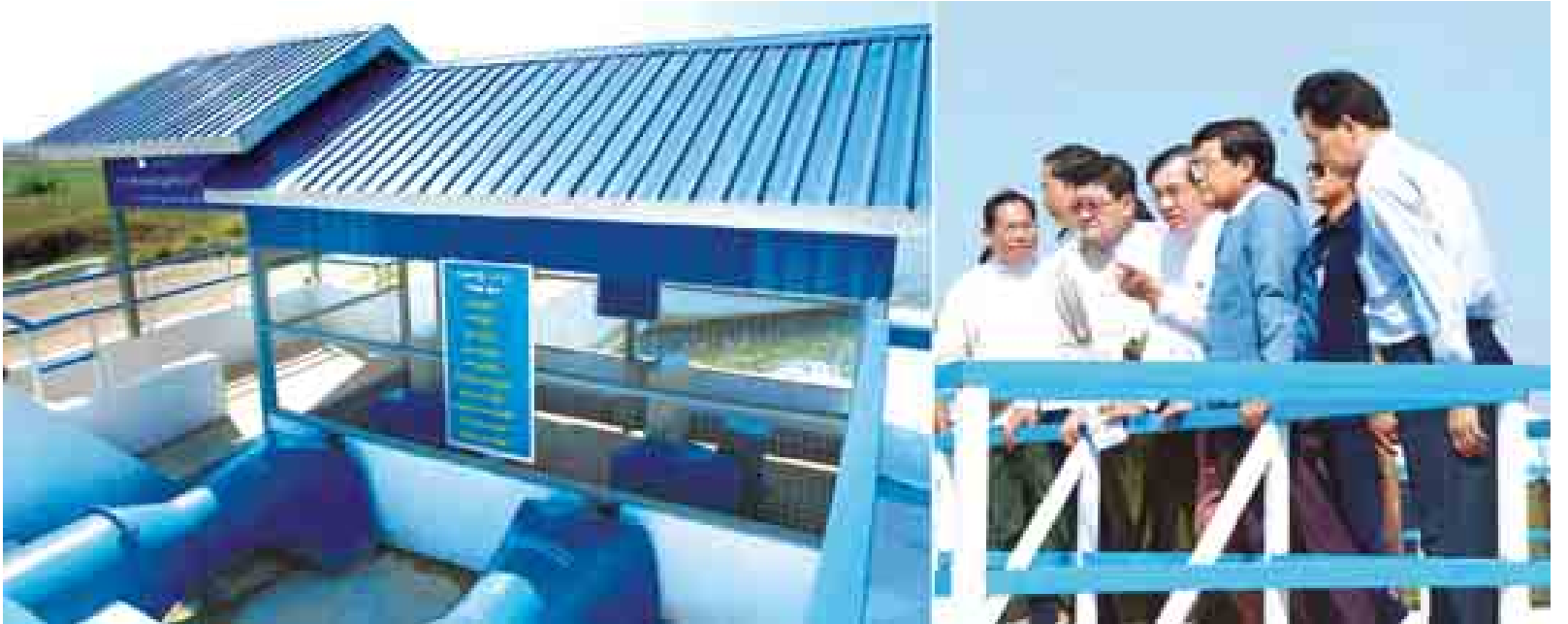
ဒုတိယသမ္မတ ဦးဉာဏ်ထွန်း ကျောက်ခွက်ကျေးရွာအနီးရှိ အသေးစားရေအားလျှပ်စစ်ထုတ်လုပ်သည့် အဆောက်အအုံကို ကြည့်ရှုစစ်ဆေးစဉ်။
