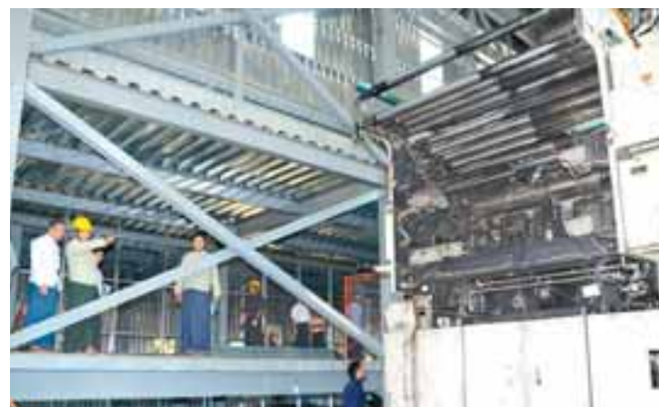
ဒုတိယဝန်ကြီး ဦးပိုက်ထွေး The New Light of Myanmar သတင်းစာတိုက် အဆောက်အအုံ တည်ဆောက်နေမှုကို ကြည့်ရှုစစ်ဆေးစဉ်။ (သတင်းစဉ်)
