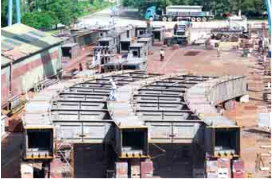
ရွှေဝဲတိုင်ခုံးကျော်တံတား၏ အမှတ်(၃)သံပေါင်ကို အမှတ်(၂)သံမဏိစက်ရုံတွင် အစမ်းတပ်ဆင်နေစဉ်။
