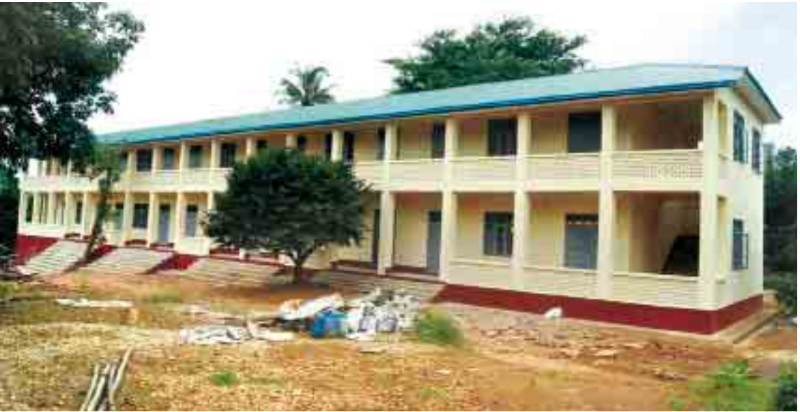
ရွှေကျင်မြို့ အခြေခံပညာအထက်တန်းနှစ်ထပ်ကျောင်းဆောင် တည်ဆောက်ထားမှုကို ဤသို့တွေ့မြင်ရသည်။
