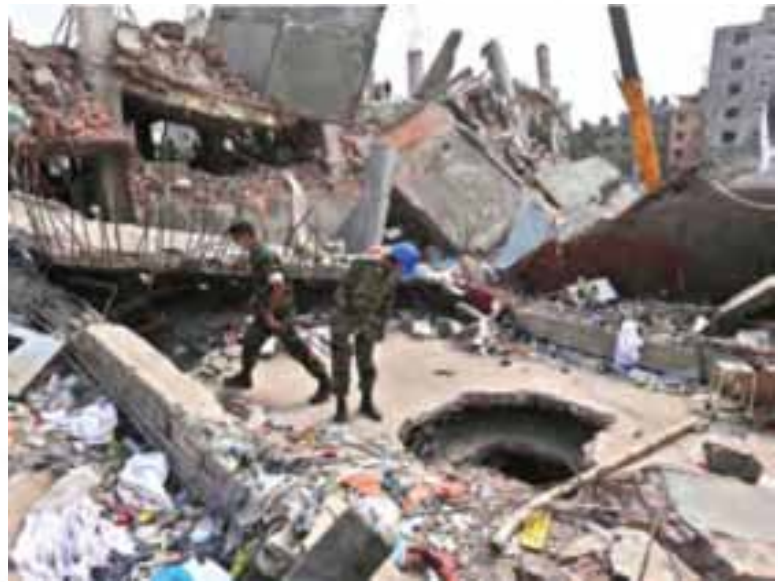
ဧပြီ ၂၄ ရက်က ပြိုကျမှုဖြစ်ပွားခဲ့သော အထည်ချုပ်စက်ရုံ အဆောက်အအုံကို တွေ့ရစဉ်။
