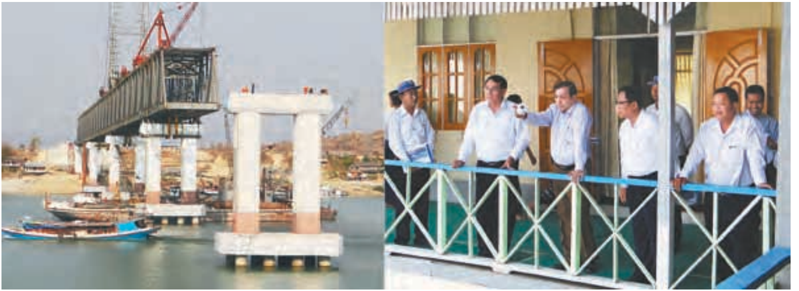
ပြည်ထောင်စုဝန်ကြီး ဦးကျော်လွင် ဧရာဝတီတံတား(ရတနာသိမ်)တည်ဆောက်ရေးလုပ်ငန်းခွင်၌ တံတားသံပေါင်များ တပ်ဆင်နေမှုကို ကြည့်ရှုစစ်ဆေးစဉ်။
