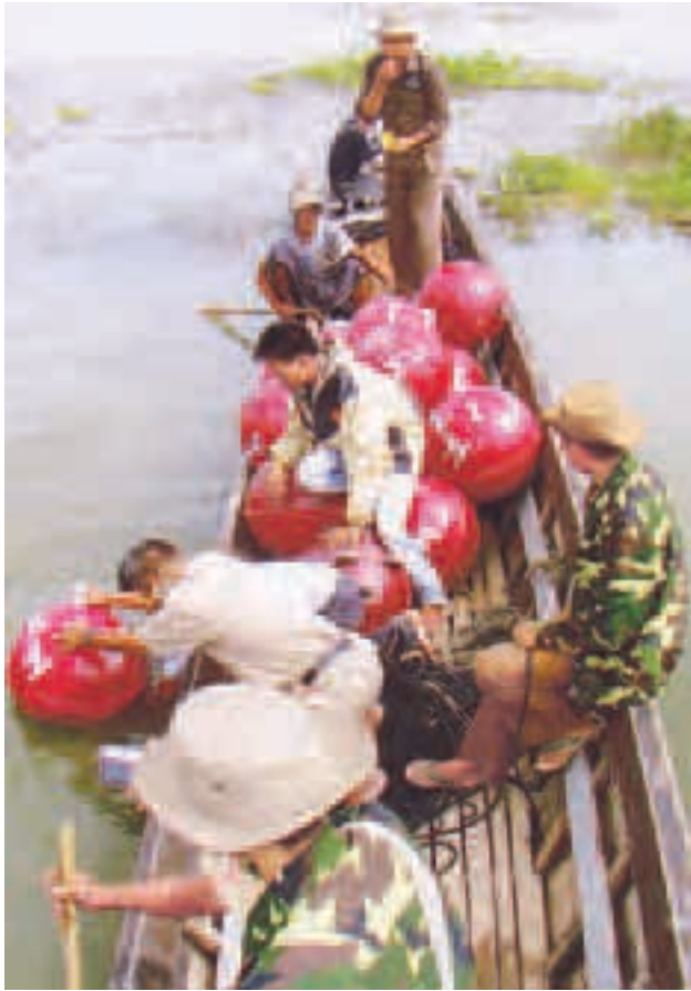
အင်းလေးကန်အတွင်း၌ နယ်နိမိတ်အမှတ်အသားများကို ငါးမွေးမြူရေးလုပ်ငန်းများတွင် အသုံးပြုလေ့ရှိသော ရေပေါ်ဘောလုံးများ နိုင်ငံလွန်ကြီးနှင့် ကွန်ကရစ်တုံးများစနစ်တကျ ချနေစဉ်။
