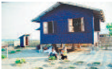
မောင်တောမြို့နယ် ရွှေရင်အေးကျေးရွာ၌ ပြန်လည်တည်ဆောက်ပေးထား သော ဦးခိုင်သိန်း၏ နေအိမ်ကို တွေ့ရစဉ်။
