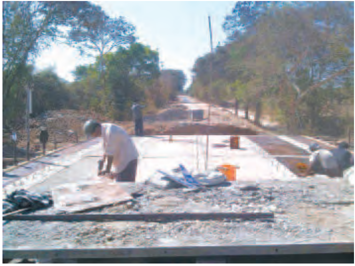
မင်းဘူး-အမ်း ကားလမ်းပေါ်ရှိ စီးအိုင်တံတား တည်ဆောက်ရေးလုပ်ငန်းခွင်ကို တွေ့ရစဉ်။
