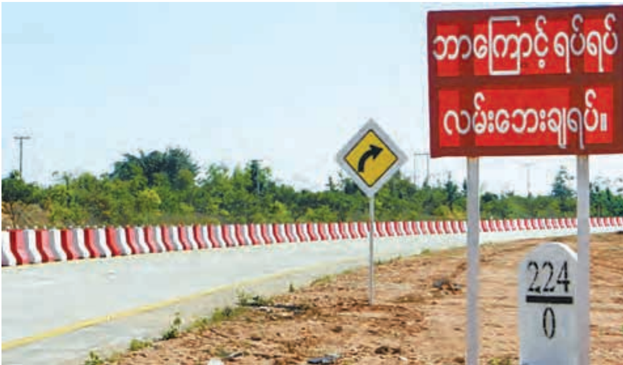
အန္တရာယ်ရှိသော လမ်းကွေ့များတွင် Concrete Barrier တပ်ဆင်ထားပုံ။
