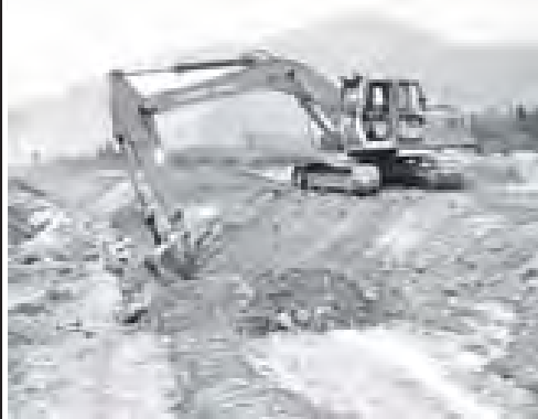
ရွှေလုံပိုလ်လျှပ်စစ်မြစ်ရေတင် စီမံကိန်း၏ လက်ကံခွဲမြောင်းတည်ဆောက်ခြင်းလုပ်ငန်း၌ ခွင် ဝတ်ယူရင်းကြီးများဖြင့် ဆောင်ရွက်နေမှုကို တွေ့ရမည်။
